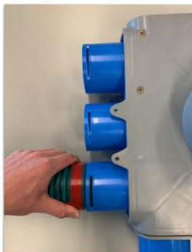
2. Pressez les lèvres avec les deux doigts et faites glisser le flexible dans le collecteur.
