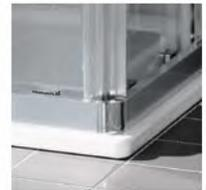
Sans profilé bas ou sans baguette, l'eau trouve librement et facilement un chemin. Pour les parois de douche posées sans baguette d'étanchéité un joint d'étanchéité horizontal en forme de gouttière réalise une étanchéité satisfaisante.
